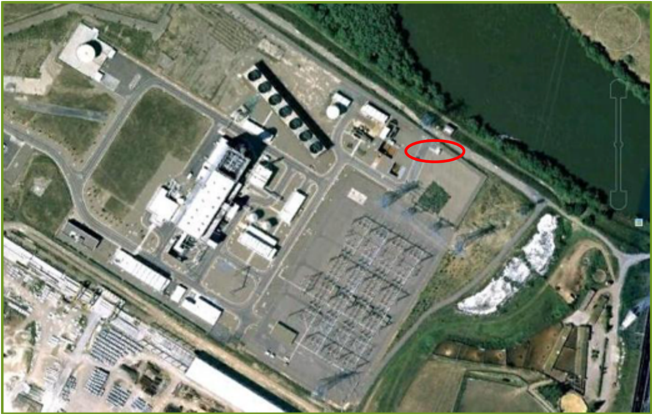
Figura 6: Arqueta de vertido final del C.C. CASTEJÓN
